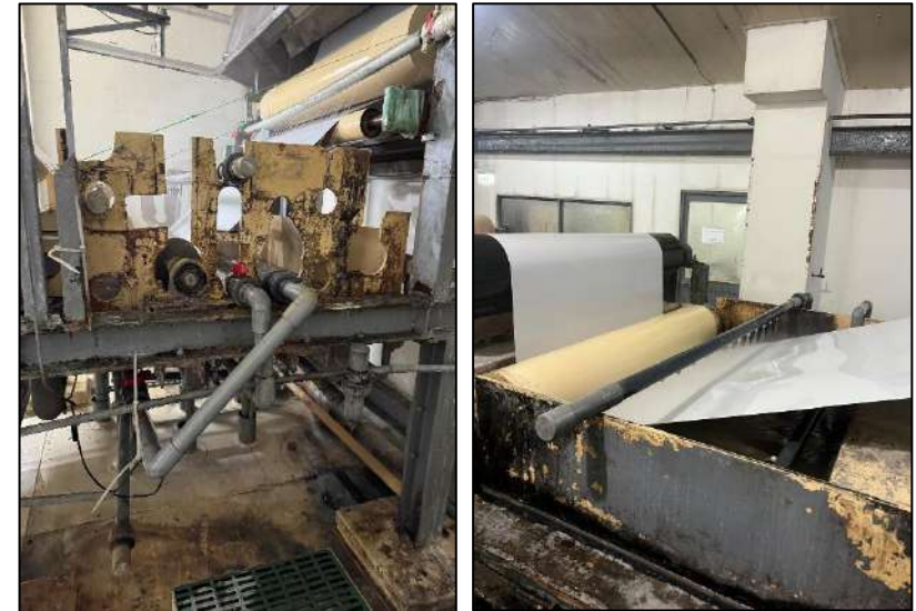
製程後端水洗水回收製程前端重覆使用
